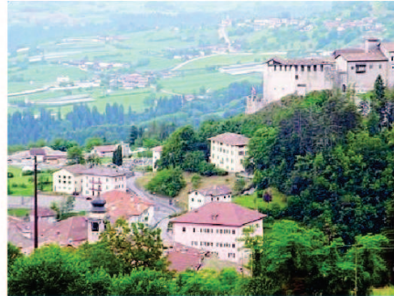
A Stenico il primo edificio col sistema antisismico
